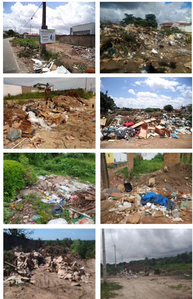
Figura 20 - Pontos de lançamento inadequado de RCC na RMGSL.
