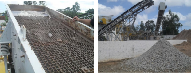
Figura 18 - Reciclagem de RCC desativada em São José de Ribamar.
