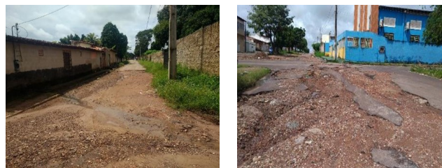
Figura 17 - Reaproveitamento de RCC em operação “tapa buraco”.
