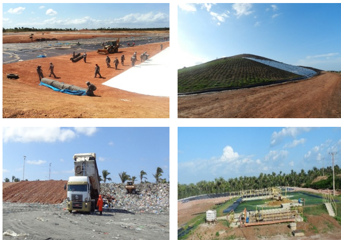
Figura 11 - Aterro sanitário Titara, em Rosário.
